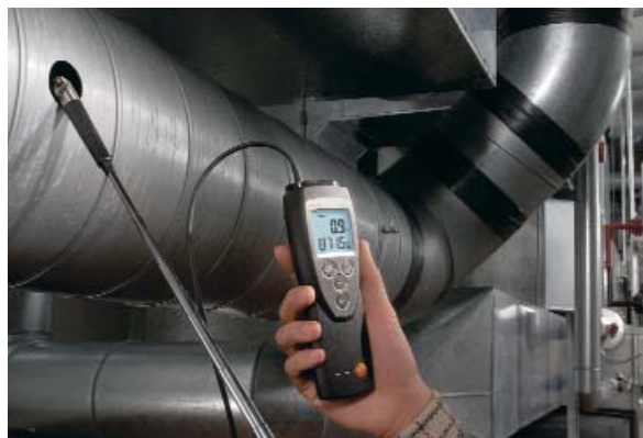
testo 416 při zjišťování objemového průtoku odsávaného vzduchu
