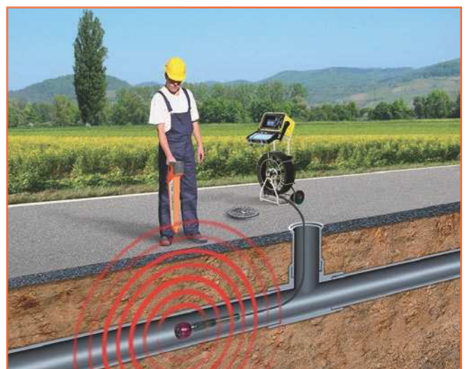
TV Kamera - vyhledávání s Easyloc Cam
